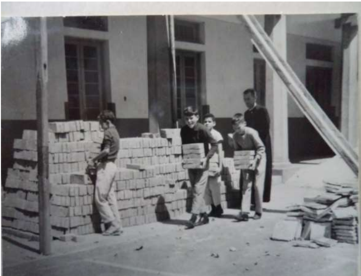
Figura 2: disciplina de construção de obras. Final da década de 1930.
