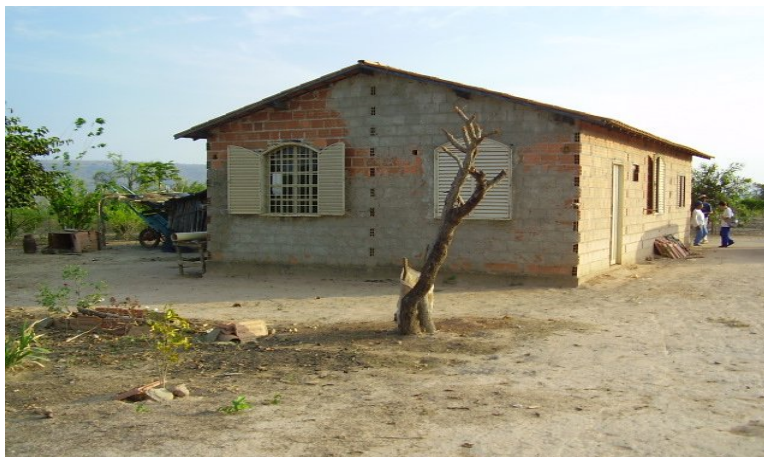
Figura -1: Sala de alfabetização Assentamento Ezequias dos Reis
